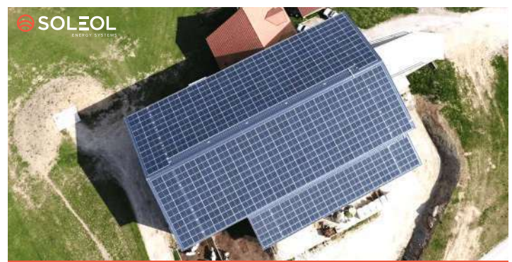
Projet à Châtel-St-Denis Panneaux 572 – Surface 1,042 m 2 – Puissance 212 kW
